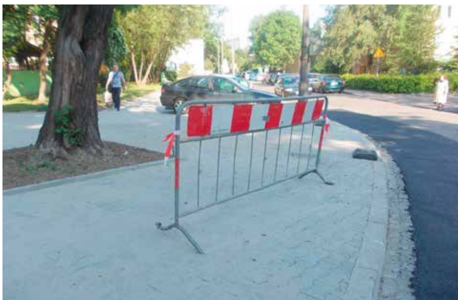
Wykonany remont chodnika przy ul. Młyńskiej Bocznej. Fot. Piotr Skowron
