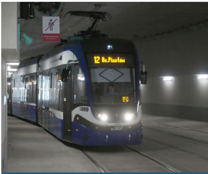
Tramwaj w tunelu wjeżdża na przystanek podziemny Rondo Polsad. Fot. Mateusz Drożdż
