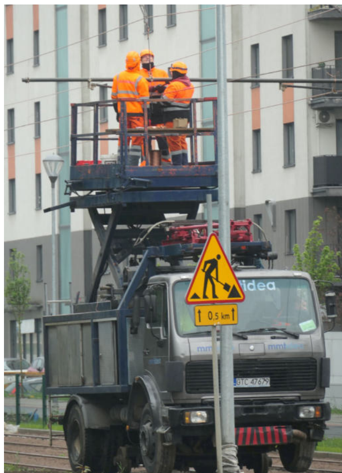
Montaż trakcji przy ul. Dobrego Pasterza. Fot. Mateusz Drożdż
