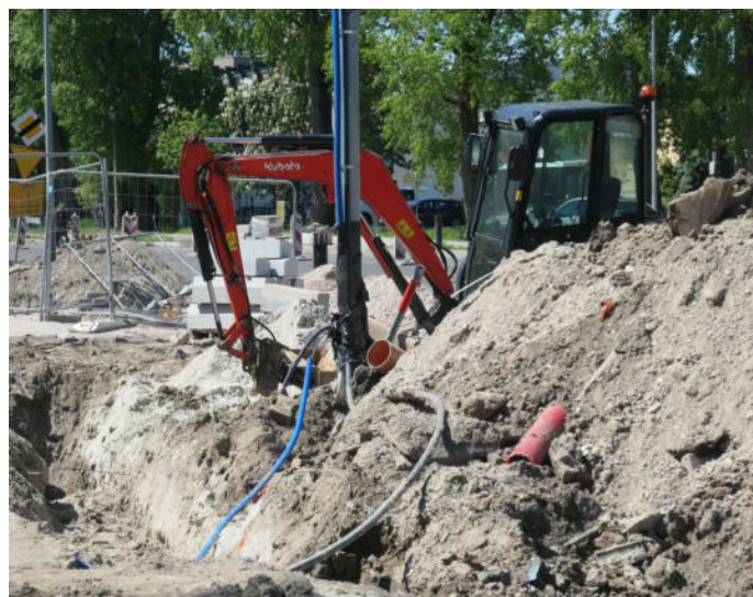
Prace ziemne przy ul. Młyńskiej. Fot. Mateusz Drożdż
