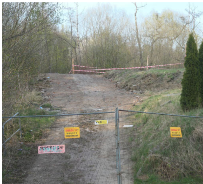
Samowola budowlana została usunięta. Fot. Mateusz Drożdż
