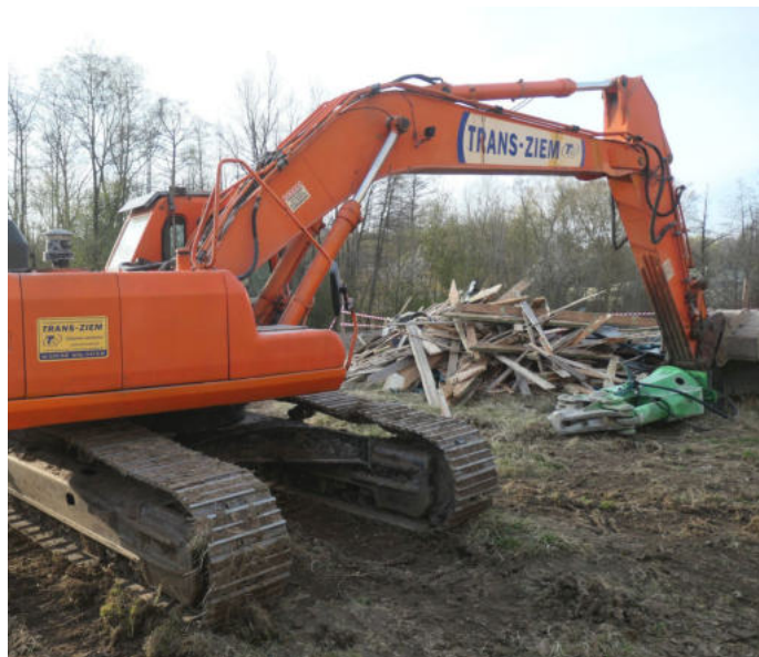
9 kwietnia 2026 r. decyzja o rozbiórce została wykonana. Fot. Mateusz Drożdż
