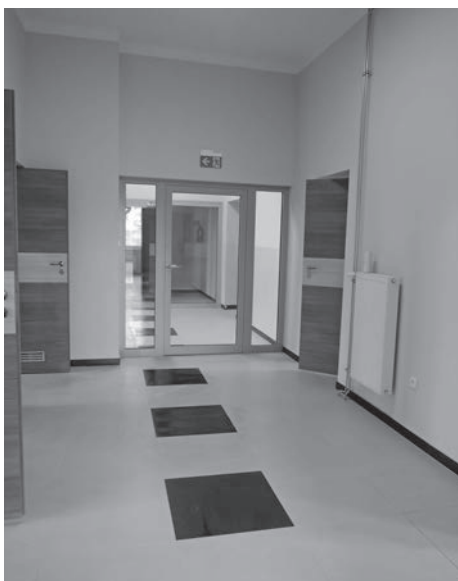
Stan po remoncie
