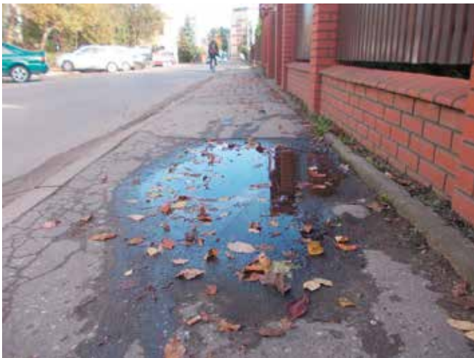
Ul. Śliczna przed remontem
