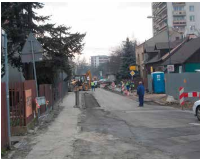
Remont części południowej ul. Ślicznej
