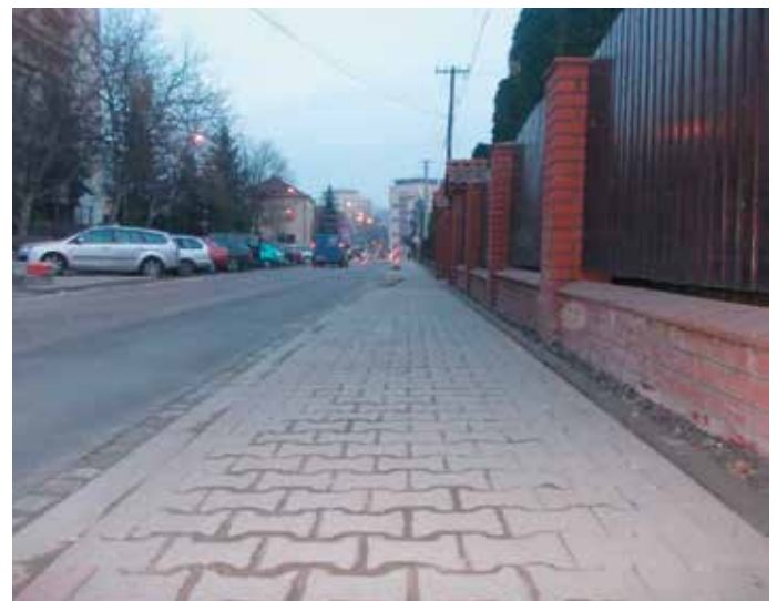
Ul. Śliczna po remoncie.
