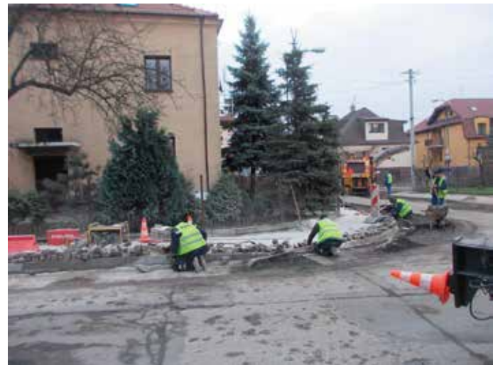
Remont części północnej ul. Ślicznej
