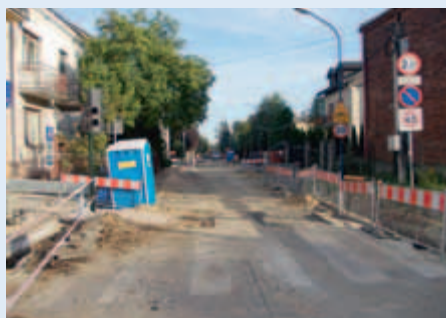
Remont ul. Widnej. Fot. Piotr Skowron
