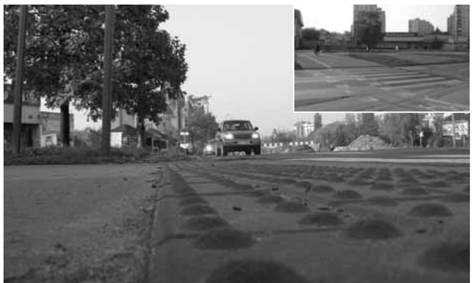
Wypustki czyli kostka kolorowa integracyjna znajdują się tuż przed jezdnią. Fot. Mateusz Drożdż
