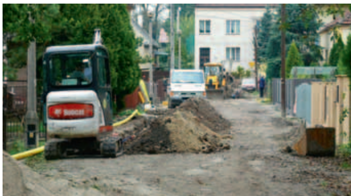
Wrzesień 2010 roku – rusza przebudowa ulicy Rokitniańskiej
