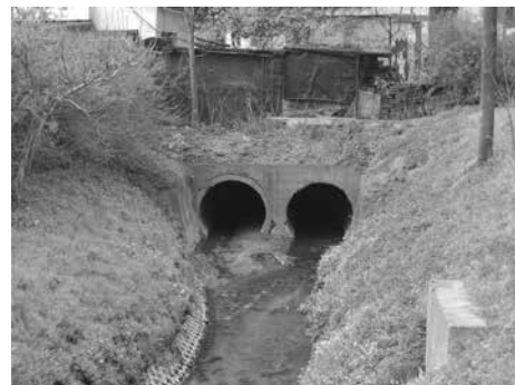
Wylot przepustu wodnego pod ul. Dobrego Pasterza. Fot. Marek Zborowski
